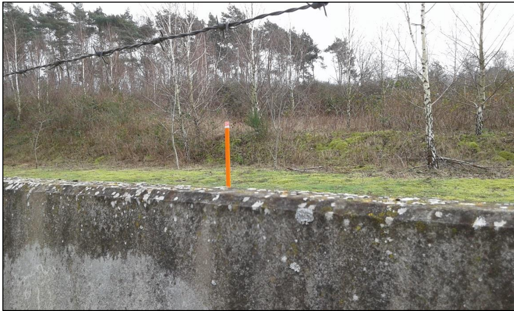
Zicht op het restant van de Eindhoutse Bosrug ten zuiden van het bedrijf met vooraan een open strook waar een ondergrondse leiding loopt.
