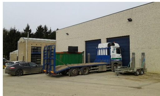
Zuid westelijke zijde van de loods met toegang voor oplegger
