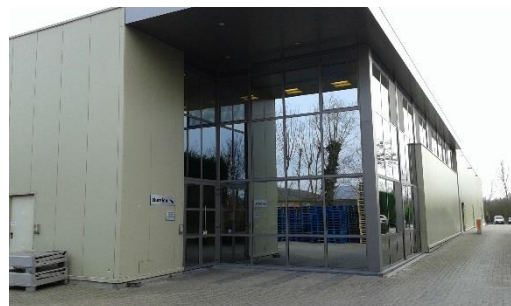
Noordwestelijk deel hoofdgebouw met kantoor
