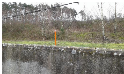
Zuidelijke beboste strook met aangeven ondergrondse leiding en betonnen L-profiel op de voorgrond
