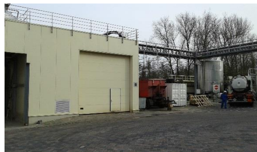
Gebouw waterzuivering met luchtbrug
